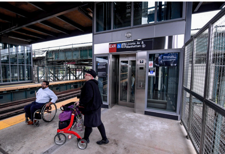
New elevators at Livonia Av L
